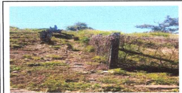
Foto 3: Reparación de muro perimetral de block con tubo hg y malla galvanizada, soleras intermedias y columnas.
