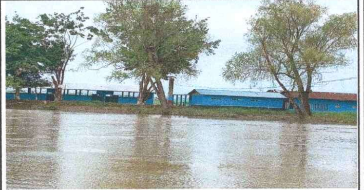
Foto 2: Se observa el establecimiento la falta de muro
